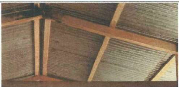
Foto 5: Sustitucion de la estructura metalica del techo. Modulo 2
