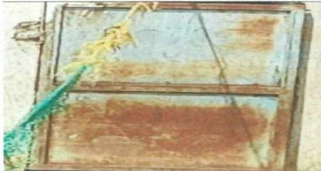
Foto 4: Sustitucion de puerta de metal modulo 2
