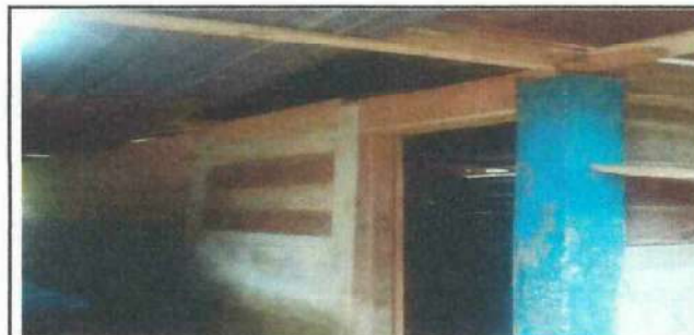
Foto 6: Mantenimiento de columnas. Modulo 2
