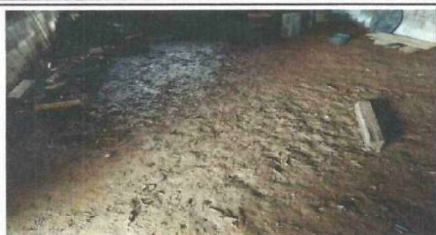
Foto 1: Sustitucion de piso de torta de cemento. Modulo 02
