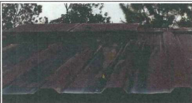
Foto 3: Sustitucion de cubierto de lamina modulo 1.
