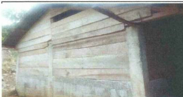
Foto 2: Rehabilitacion de paredes modulo 2
